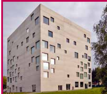
SANAA und Heinrich Böll Architekt BDA, Zollverein School of Management and Design, Essen 2002–2006
