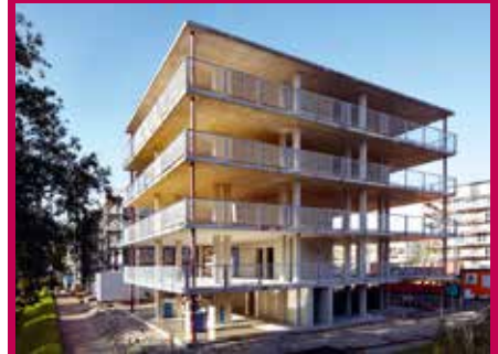
BeL, Mehrfamilienhaus Grundbau und Siedler, Hamburg 2012–2013
