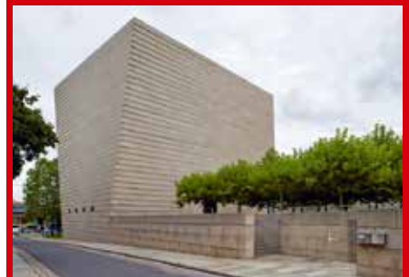
Wandel Hoefler Lorch, Neue Synagoge, Dresden 1998–2001
