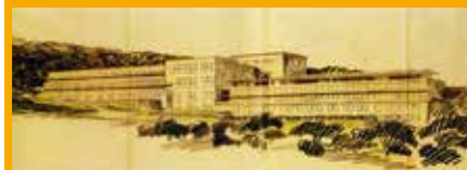
Richard Döcker, Krankenhaus Knittlinger Steige, Maulbronn 1927–1929
