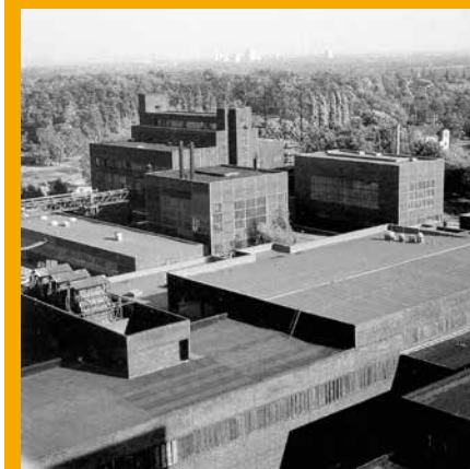
Fritz Schupp und Martin Kremmer, Zeche Zollverein, Schacht XII, Essen 1927–1932
